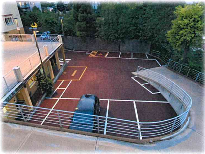
Rifacimento della pavimentazione del piazzale inferiore di Hospice Albaro.
